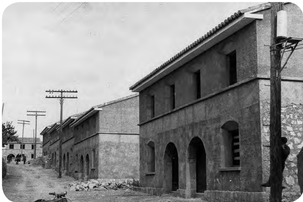
Fig. 52 Construcción de las viviendas del Barrio de Capuchinos. Foto A.M.T.
