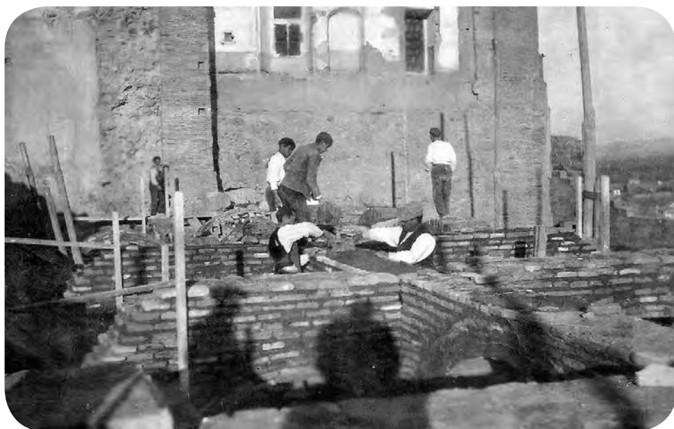
Fig. 37 Reconstrucción del convento tras el hundimiento de 1922.
