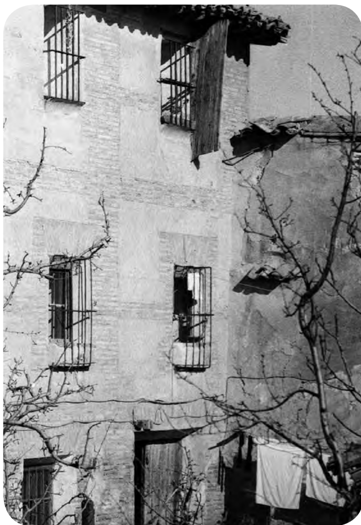
Fig. 55 Alzado. Vista desde el patio interior. Estado en 1982. Convento de Santa Ana. Foto arquitecto Francisco Miguel Barseló.
