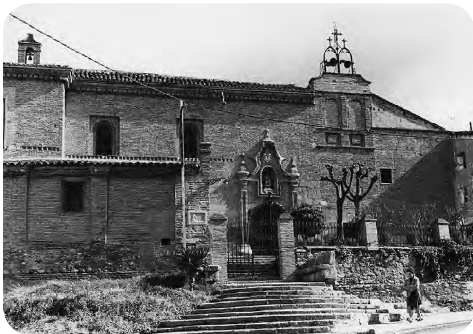
Fig. 54 Fachada principal del convento de Santa Ana. Estado en 1982, antes de la intervención de Francisco Miguel Barseló. Foto Archivo del Centro de Estudios Turiasonenses.
