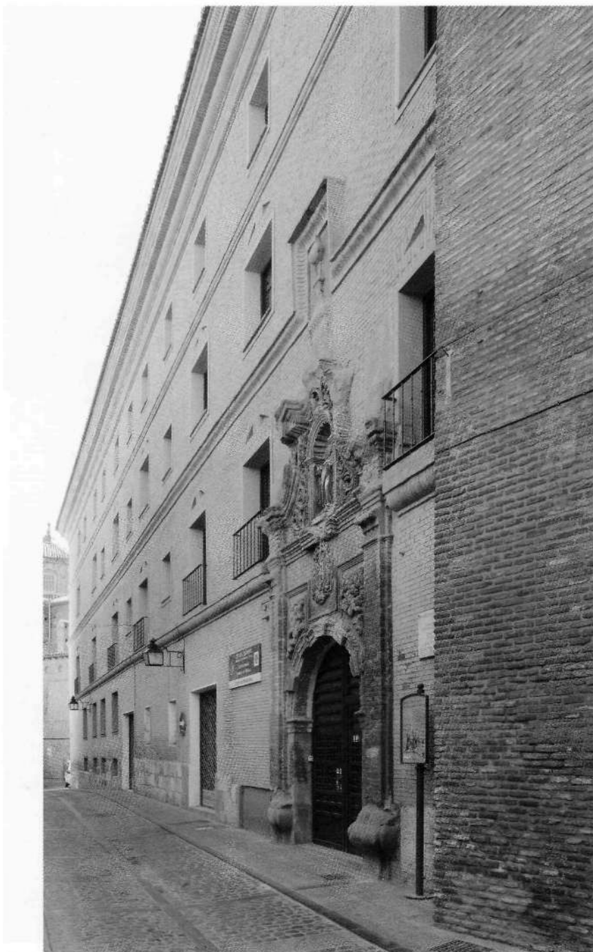
Fachada principal del convento. Foto José Latova.
