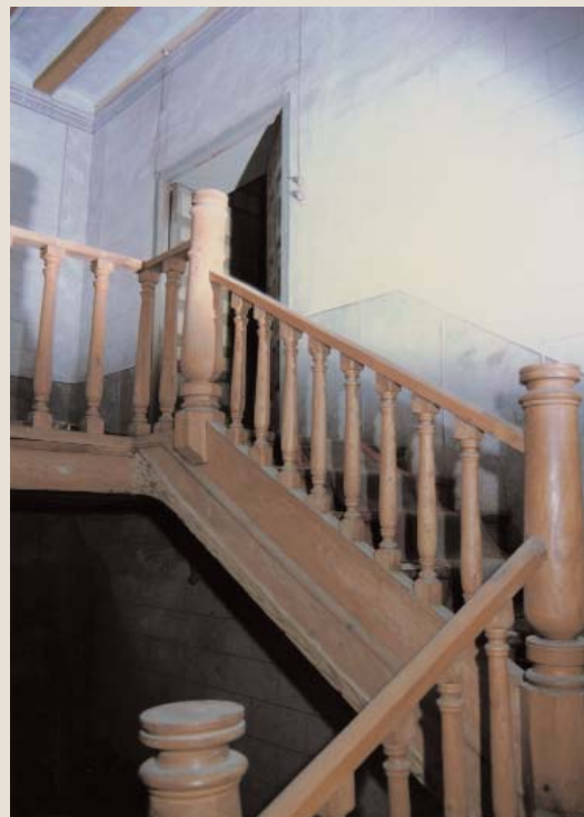
Escalera de acceso al piso noble del ala este en 1994 Fotos Rafael Lapuente
