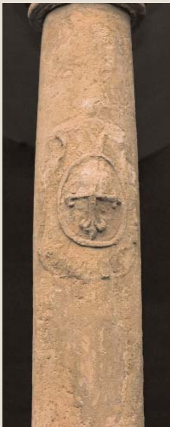
Columna del corredor oriental Foto Rafael Lapuente
