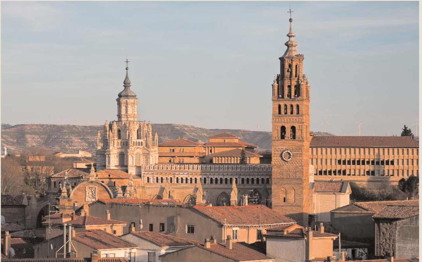
Panorámica exterior de la catedral de Tarazona
