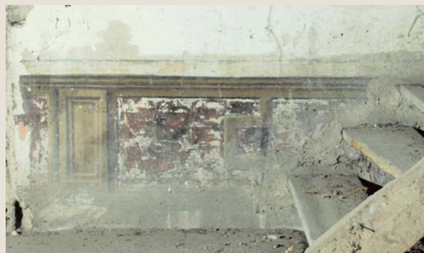
Restos del zócalo pictórico de la cámara central del ala norte
