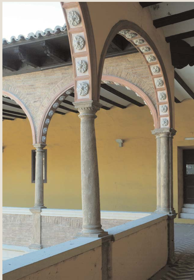
Arquería de los corredores del patio
