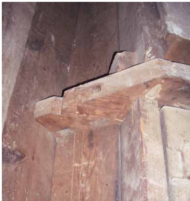
Fig. 57. Doble cola de milano en un empalme entre tablas. Retablo mayor de la catedral de N a S a de la Huerta de Tarazona. Foto Olga Cantos.
