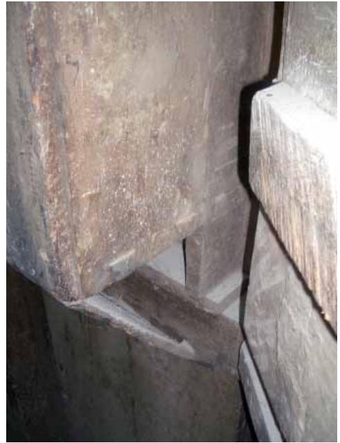
Fig. 54. Ensamblajes de caja y espiga, refuerzo con barrotes en cola de milano y aldabilla. Retablo mayor de la catedral de N a S a de la Huerta de Tarazona. Foto Olga Cantos.
