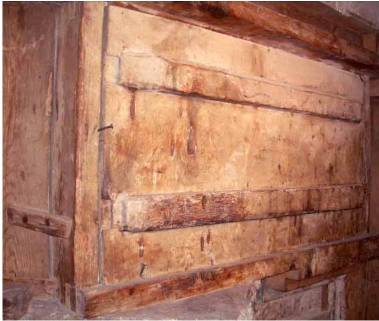
Fig. 54. Ensamblajes de caja y espiga, refuerzo con barrotes en cola de milano y aldabilla. Retablo mayor de la catedral de N a S a de la Huerta de Tarazona. Foto Olga Cantos.
