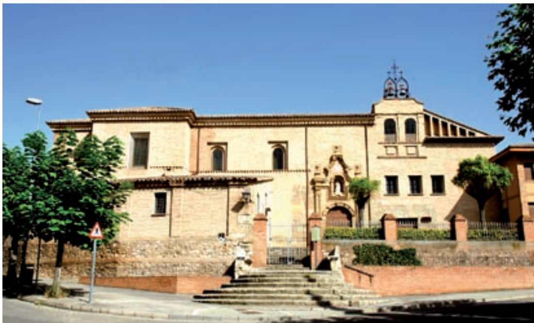
3. Exterior del convento de carmelitas descalzas de Tarazona. Foto Rafael Lapuente.
